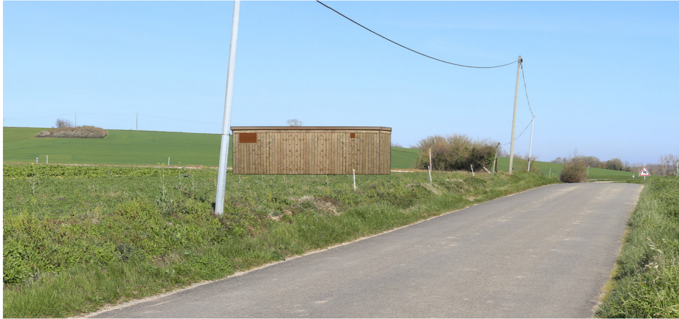
Fig. 446 : Intégration du poste de livraison, vue depuis la D88
