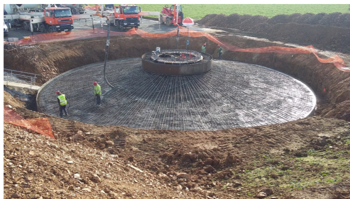
Fig. 433 : Mise en place d'une fondation
