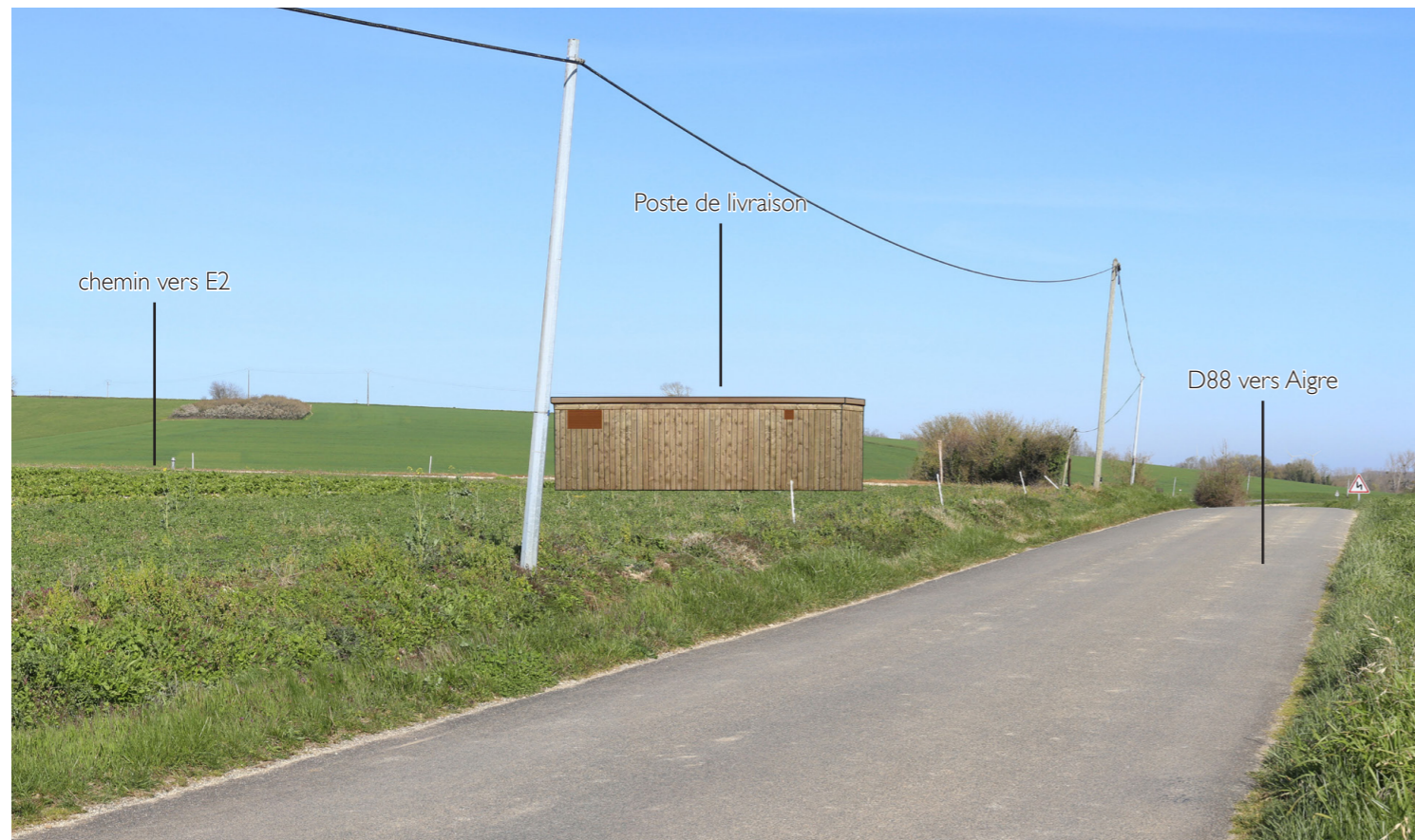
Fig.438 : Intégration du poste de livraison le long du chemin menant à l'éolienne E2
